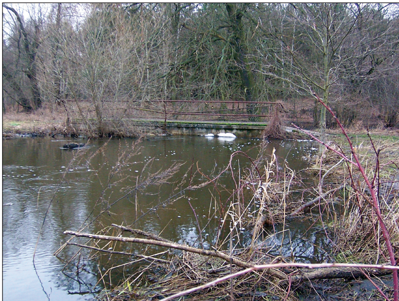
An der einzigen Brücke über die Dahme zwischen Staakmühle und Freidorf staut sich das Wasser an der Unterkante der Betonkonstruktion.
